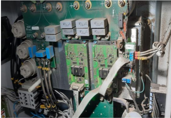
4-REPARO EM PLACA RAIO-X
